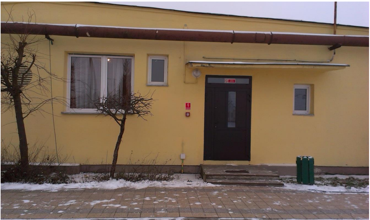
Fot. nr 4. Elewacja wschodnia- widok ogólny
