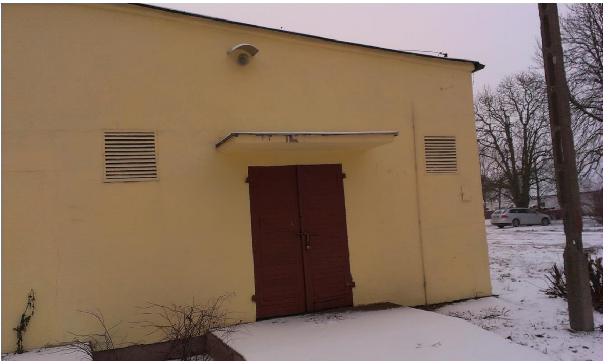
Fot. nr 2 Elewacja zachodnia- widok ogólny
