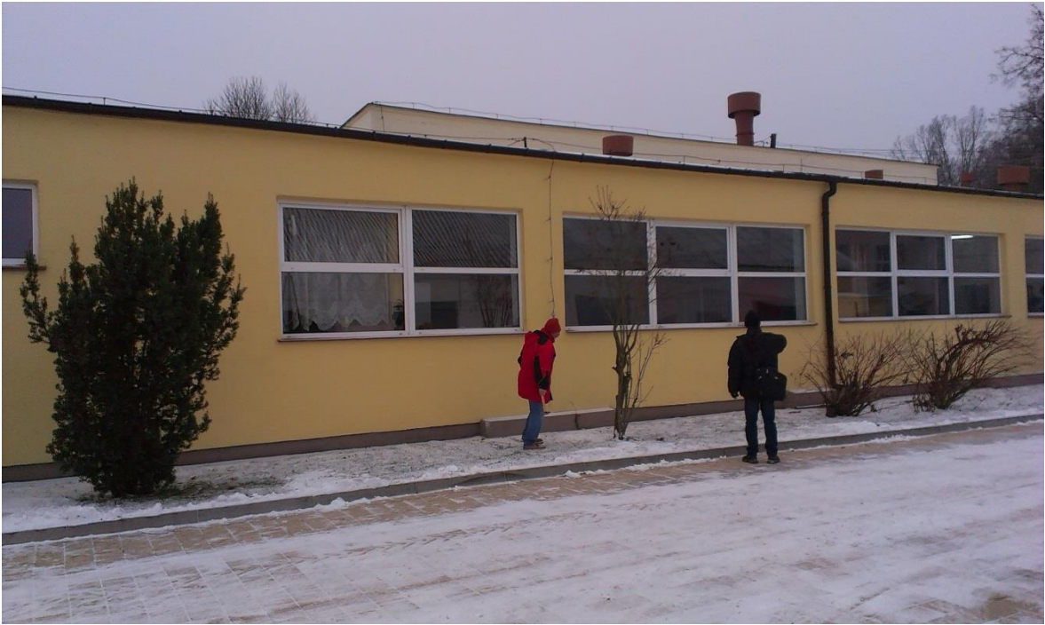
Fot. nr 1. Elewacja północna- widok ogólny
