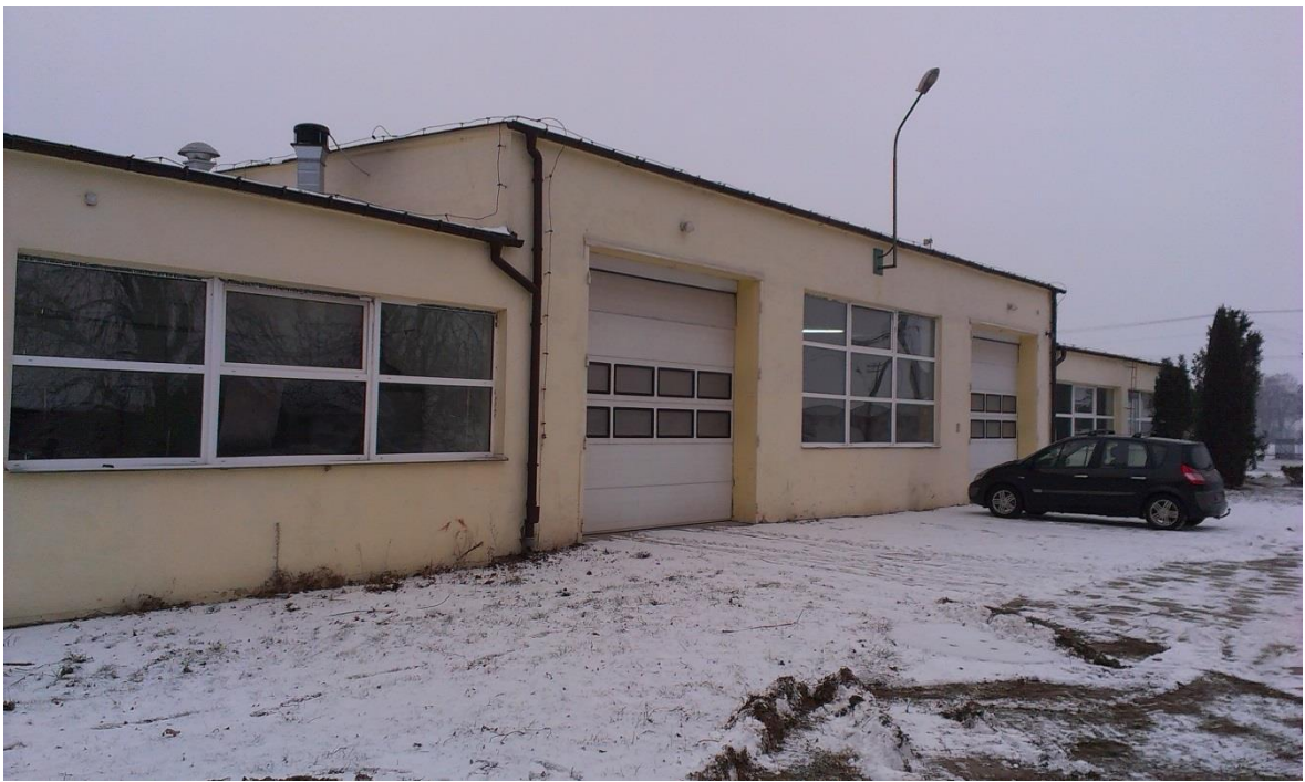
Fot. nr 3. Elewacja południowa- widok ogólny
